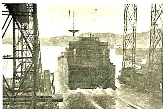
写真5 東靖丸, 第3船台から進水する後部船体
