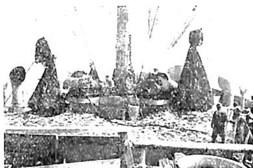
4. 両舷取り（左右両舷より同時に ヘッド・エンド2個をうけとる）
