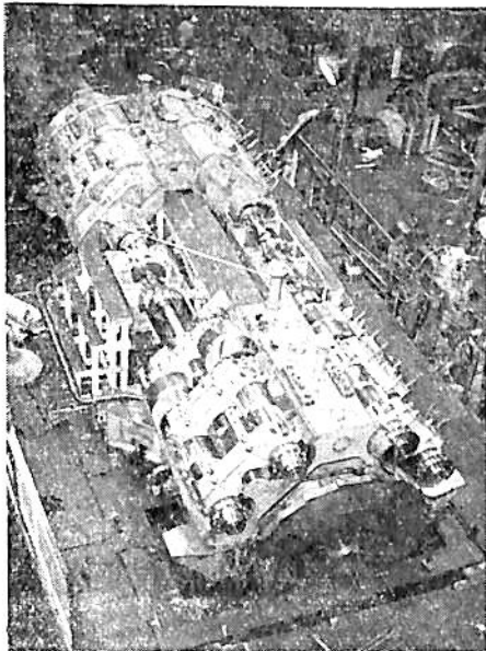
第 5 図 Front-to-front 負荷試験 (新三菱重工業の御好意による)
