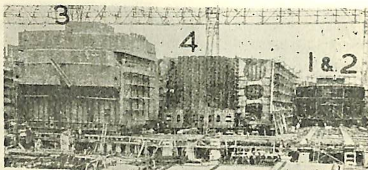
Fig. 10 貨物船の輪切建造 (Deutsche Werft)
