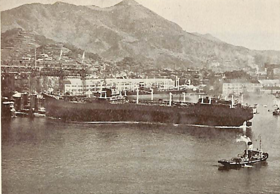
87,500重量トンタンカー「ネス・サブリン号」船台をすべりおろる (35-6-27)
