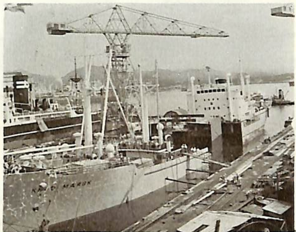
玉野造船所 才 4 ドックで船体延長工事のため、中央部において切断されたクヌード・メルスク号が、新造の延長部船体をはさんで再入渠したところ。
