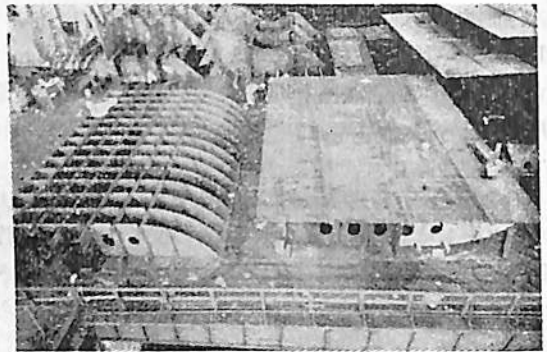
第1図 内部船底のエッグクレート構造区域
