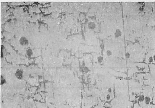
第15図 比較的初期に発生する網目状き裂 (×20)
