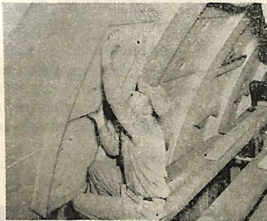
第 8 図 ポリエチレン遮蔽板のとりつけ
