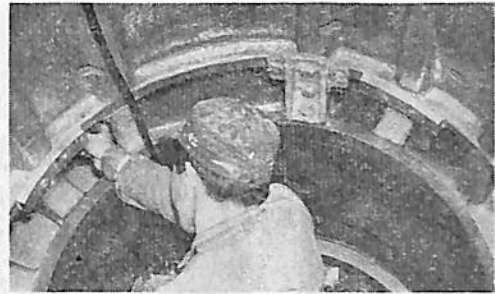
第7図 大型ディーゼル機関のシリンダー亀裂を修理中のところ
