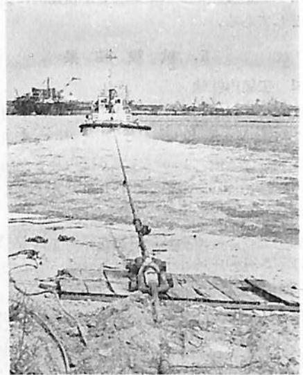
第 10 図 繫留曳航試験風景
