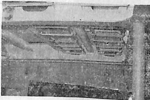
ハンガーを天井に取付けた状況
