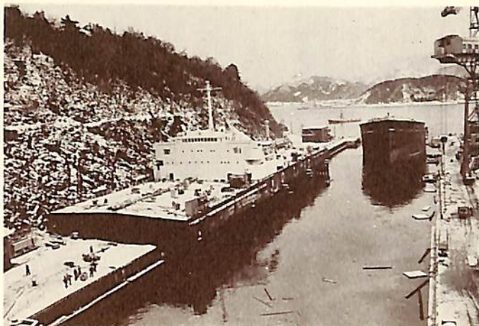
帯状新設部上甲板を受取りに船首船体が入渠する
