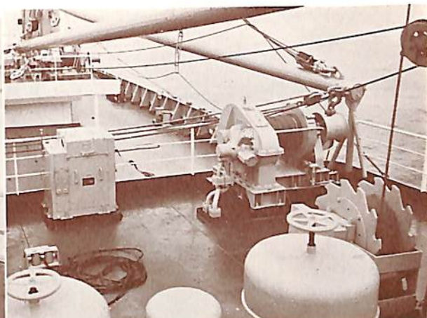
KBC 油圧カーゴウインチ、トッピングウインチ
