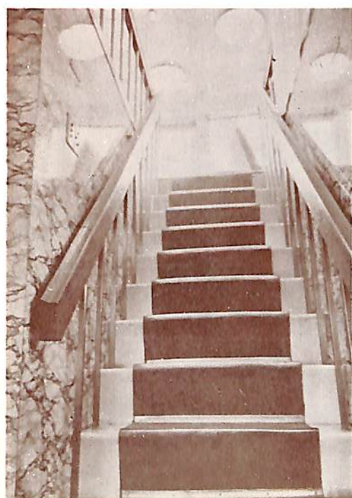
エントランスホールより階段を見る 階段はポリカーボネード製
