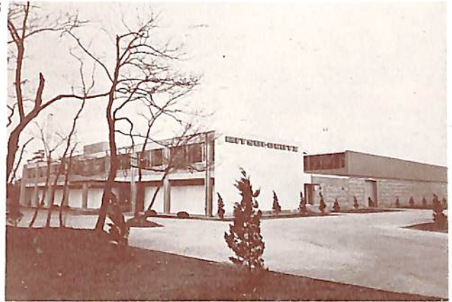
昭島工場の外観
