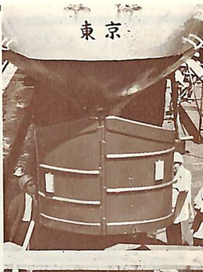
舵板を開いたところ (片舷70°)
