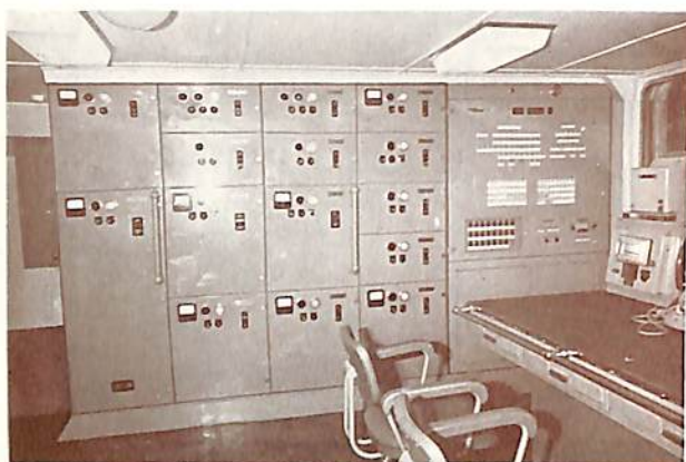
機関制御室（ログテーブル，エンジンモニター， 補機集中制御盤）
