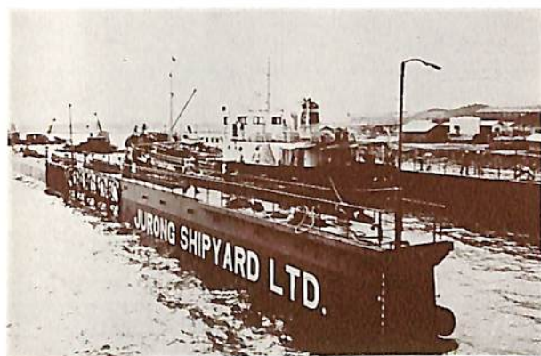
ジュロン造船所浮ドックで工事中の甲陽丸
