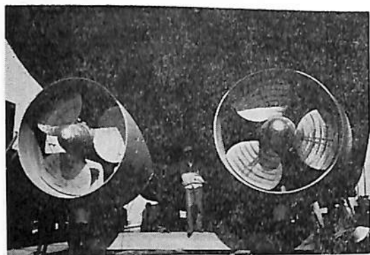
可変ピッチプロペラおよびコルトノズルラダー取付完了
