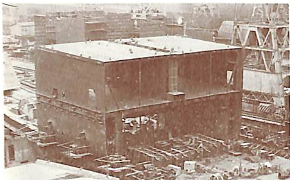
39.9.19 (進水41日前) 立体ブロック取付始め
