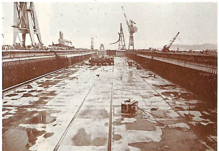
建造ドック（リベリヤ向油槽船建造開始）
