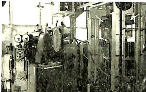
⑤ アムスラーパルセーター（右上の矢印のI梁の曲げ疲労試験を行っているところ）
