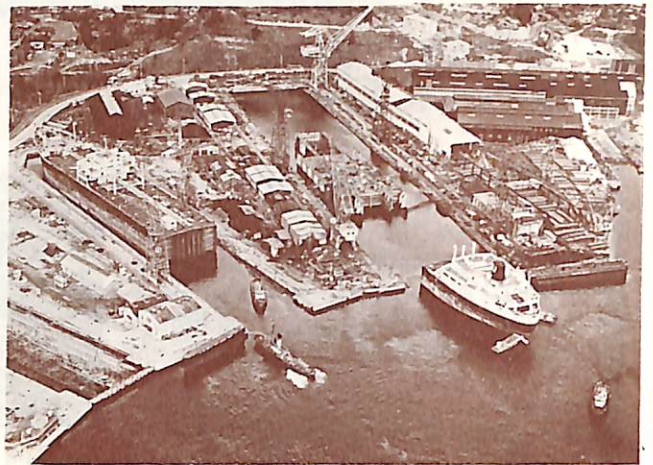
第3ドック(左)で切断された旧船体船尾部が、第4ドック(右)にタグボートで運ばれるところ。 第4ドック中央部に建造中の新造船体部がみえている。
