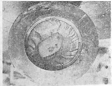
図18 支柱ボルトの切損破面
