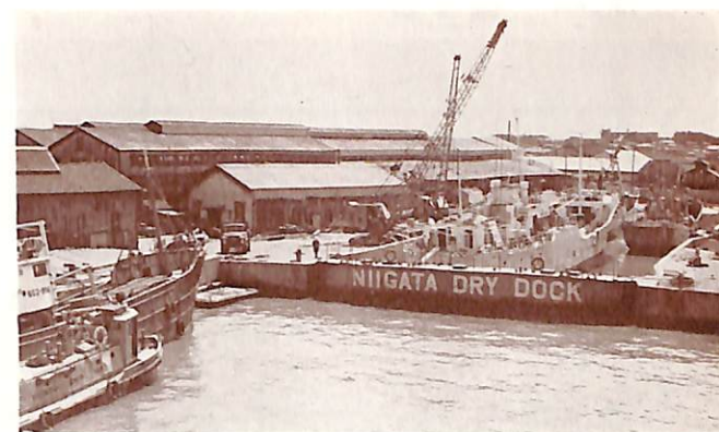
ドックを締めきって配水中
