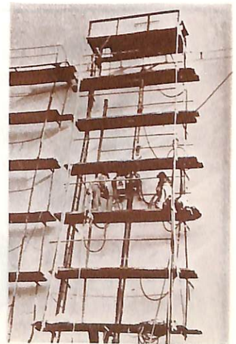
船台上でのブロック溶接法を実施中の立向自動溶接法
