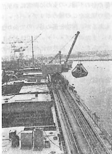
写真-1 走行デッキ・クレーンの1例
