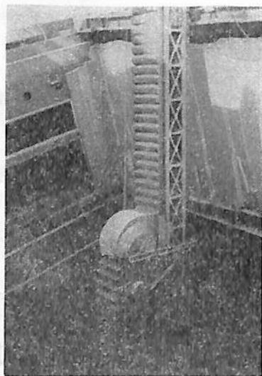
写真-5 バケット・コンベア(ホールド内)
