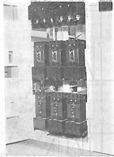
図10 ヒューズ付埋込しや断器を組み込んだ船用配電盤
