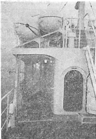
写真-3 膨脹式救命筏（右下は 機関室遠隔操作式 消火装置用 CO 2 ガスボンベ格納庫）
