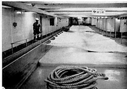
上甲板作業区画 (網の下がケーブルタンク ベルマウス)
