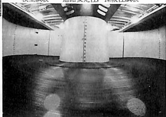
ケーブルタンク
