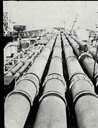
NBC 276,000 D/W. Deck. Pipe, Valves その他附屬品に対し Dimetcote およびAmercoat 塗装。
