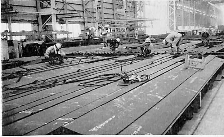
写真 8 3F 棟では形鋼のけ書き、切断、曲げ加工をしているが、4F 棟が完成すれば全面的に 4F へ移設する。
