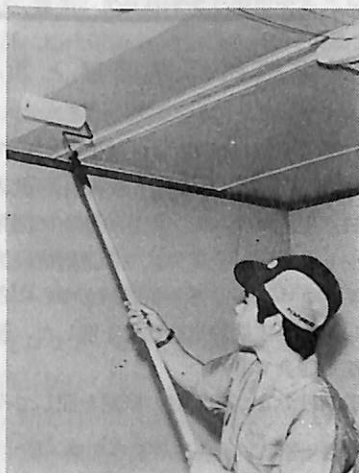
イージーローラーで天井の塗装
