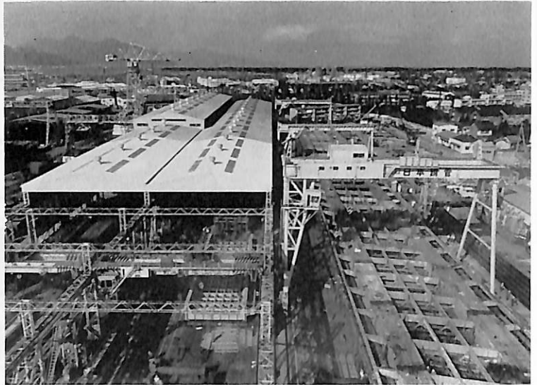
長さ242m、幅30mに拡張され、日本ではじめて50t門型クレーン1基、10t門型クレーン2基を備えている
