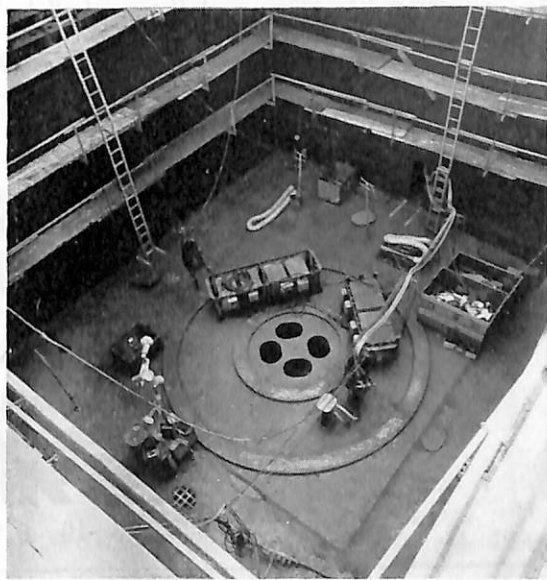
写真 3 原子炉室（中央円形部分は格納容器据付台座）
