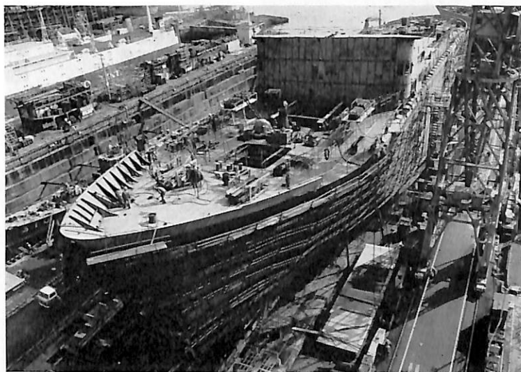
⑤ 上甲板下の船体は船首部を除きほぼ出来上った。船体中央やや後方の大きい開口は原子炉室工事用開口である。進水後この開口より遮蔽用重コンクリートが充填され、原子炉格納容器が搭載される。(44年4月25日)
