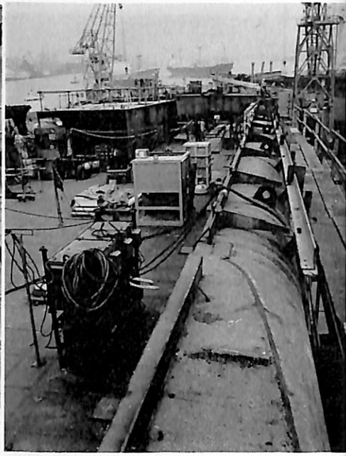
⑨ 船体中央部、上甲板舷側部を示す。本船の上甲板舷縁部は、いわゆる「ラウンドガンネル」形式となっている。原子炉室範囲のラウンドガンネル及び上甲板は各々 32 mm、38 mm の厚鋼板を使用し、対衝突防護構造の一部を兼ねている。(44年 3月 28日)
