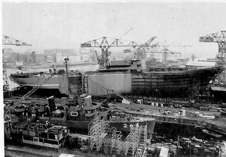
⑦ 進水前約半ヶ月前の全景。右舷側よりみる。中央上部構造は最上層甲板室を除き搭載完了。後部上部構造は進水後、搭載する。 (44年5月29日)
