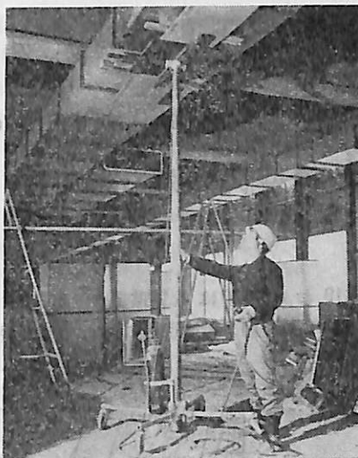
イワタニ CO 2 アッパーを使つて作業
