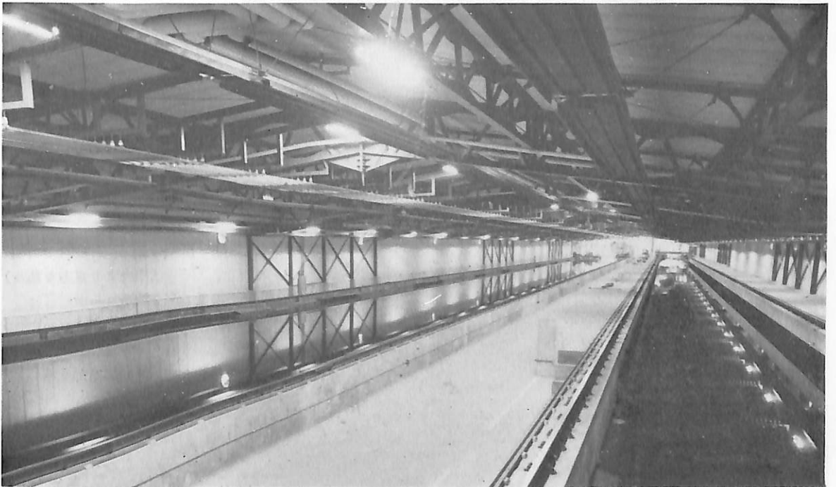
② 水槽室全景（東端より見る） 左：第1水槽 右：第2水槽
