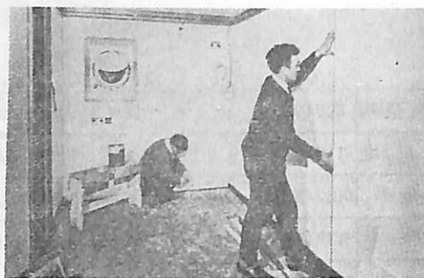
「クイーン・エリザベス2世号」の船上で、 「ネオブレン」接着剤を用いて金属性くり型 ストリップを固定している。
