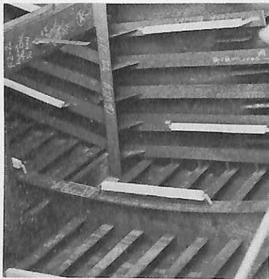
アルミ陽極取付 バラストタンク
