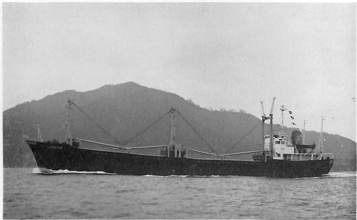
LAGUNA (貨物船) 船主 Lavina Shipping Inc. (リベリア) 造船所 波止浜造船株式会社 総噸数 3,992.90 噸 純噸数 2,493.00 噸 遠洋 船級 AB 載貨重量 6,223.32 噸 全長 110.84 m 長(垂) 101.90 m 幅(型) 16.40 m 深(型) 8.10 m 吃水 6.655 m 滿載排水量 8,499.12 噸 凹甲板型 主機 補発 6 UET 45/75 C 型ディーゼル機関 1 基 出力 3,230 PS×218 RPM 燃料消費量 12.4 t/d 航続距離 10,000 海里 速力 12.7 ノット 貨物倉(ベール) 8,206.78 m 3 (グリーン) 8,621.93 m 3 燃料油倉 A 79.74 m 3 C 491.80 m 3 清水倉 444.17 m 3 乗員 30 名 工期 45-7-15, 45-10-12, 45-12-16
