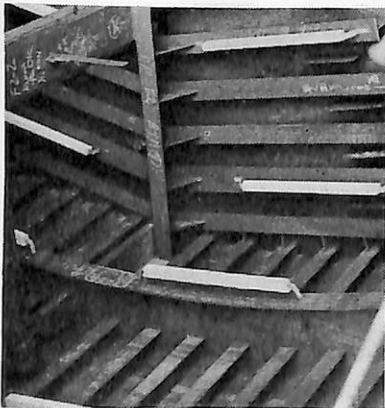
アルミ陽極取付 バラストタンク
