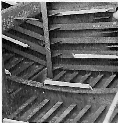
アルミ陽極取付 バラストタンク
