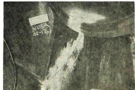
図 I-2-2 台板主軸受部のき裂 (470 mmφ)
