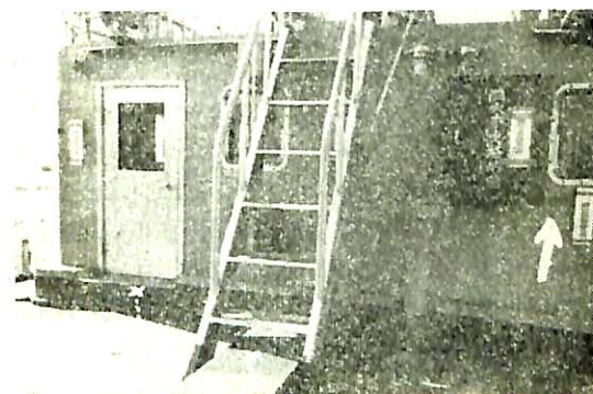
写真6 ダクトブリッジ
