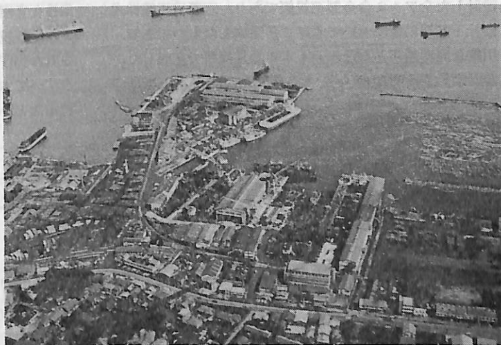
檜崎造船本社工場の全景
