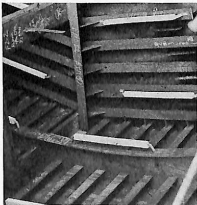
アルミ陽極取付 バラストタンク
