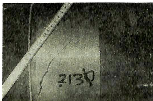
図Ⅳ.2-1 プロペラ軸ゴム巻下に生じたき裂の例
