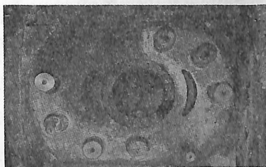
図IV-6-2 羽根取付けボルトの折損とボス合せ面の腐食の例
