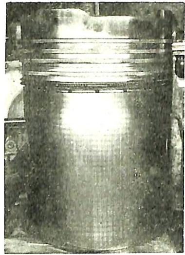
写真13 ピストン摺動面
