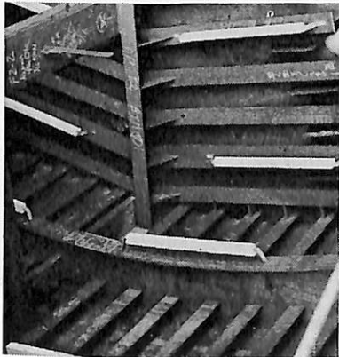
アルミ陽極取付 バラストタンク
