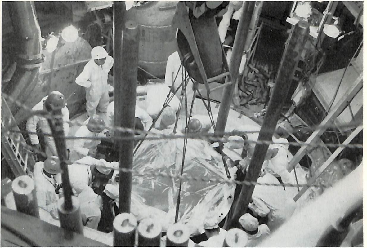
原子炉格納容器内で原子炉関係機器をぎ装中
