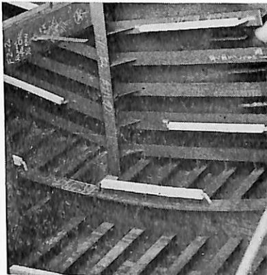
アルミ陽極取付 バラストタンク
