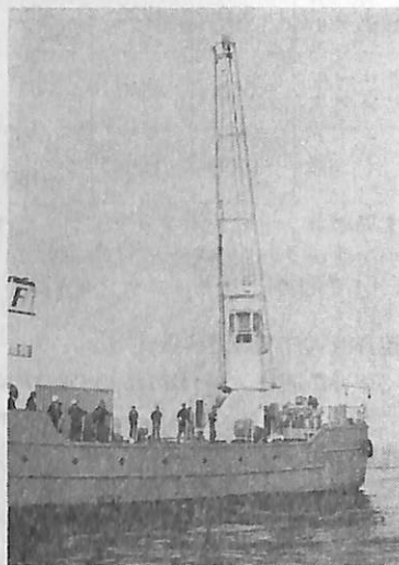
デッキクレーン
