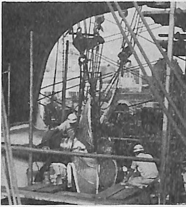
写真-3 実船用プロペラの取り付け状況
