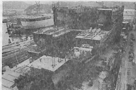
建造中の機関室
