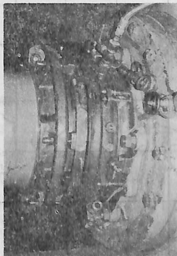
写真 3 丹波丸に取付けられた封水装置
