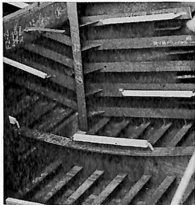
アルミ陽極取付 バラストタンク
