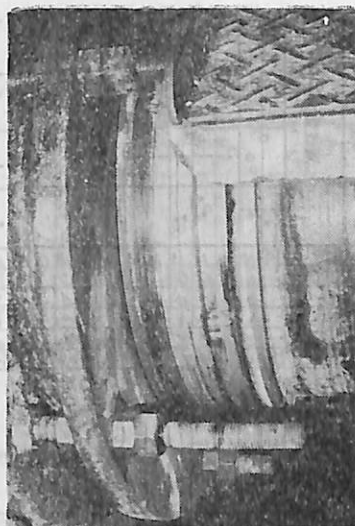
写真 2 換装前の軸封部
