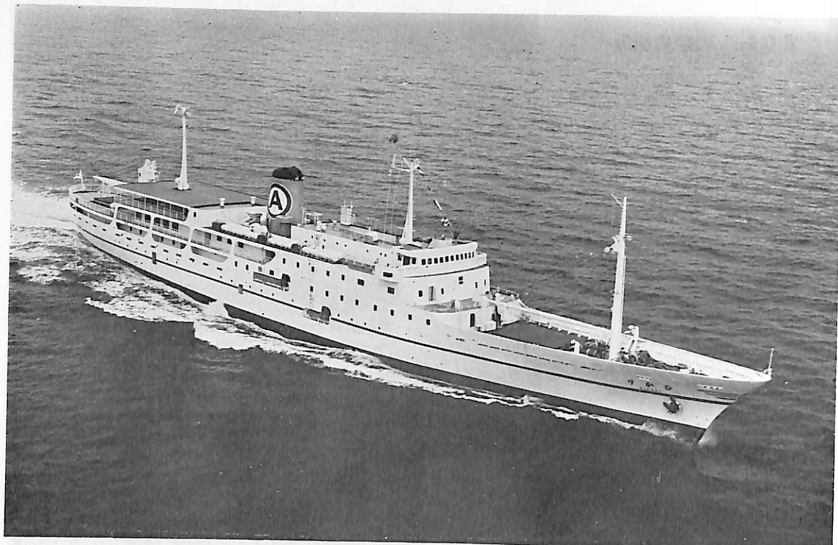
ひかり (貨客船) 船主 大島運輸株式会社, 船舶整備公団 造船所 三菱重工業・下関造船所 総噸数 3,122.56 噸 純噸数 1,803.02 噸 近海 船級 JG 載貨重量 1,196.2 噸 全長 111.35 m 長(垂) 100.00 m 幅(型) 13.90 m 深(型) 6.20 m 吃水 4.817 m 満載排水量 3,593.7 噸 全通船楼甲板型 主機 三菱 8 UET 45/75 C 型ディーゼル機関 2 基 出力 2 \times 4,250 \text{ PS} \times 218 \text{ RPM} 燃料消費量 32.2 t/d 航続距離 4,800 海里 速力 21.00 ノット 燃料油倉 396.28 m 3 清水倉 305.46 m 3 旅客 1,003 名 乗員 46 名 工期 46-11-8, 47-3- 2, 47-6-13 設備 パウスラスタ, アンチローリングタンク
