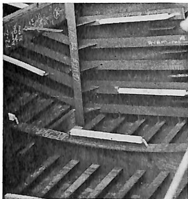
アルミ陽極取付 バラストタンク
