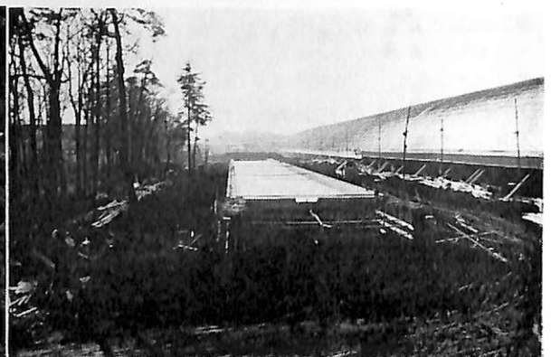
写真2 水槽本体満水テスト、右側が400 m水槽
