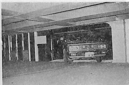
第4層カーデッキに設けられたバルクヘッドポート
