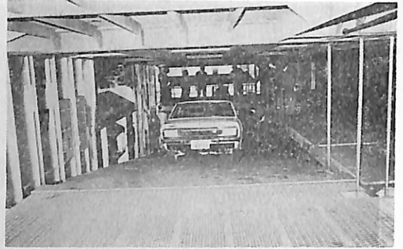
前後のリフトブルデッキを利用した傾斜路
