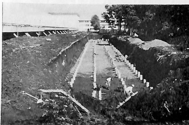
写真1 掘さくおよび杭打ち完了、左側が400 m水槽
