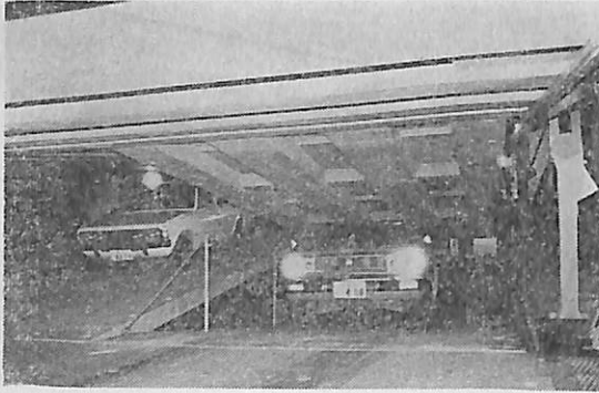
ボンツーンカーデッキを利用した傾斜路
