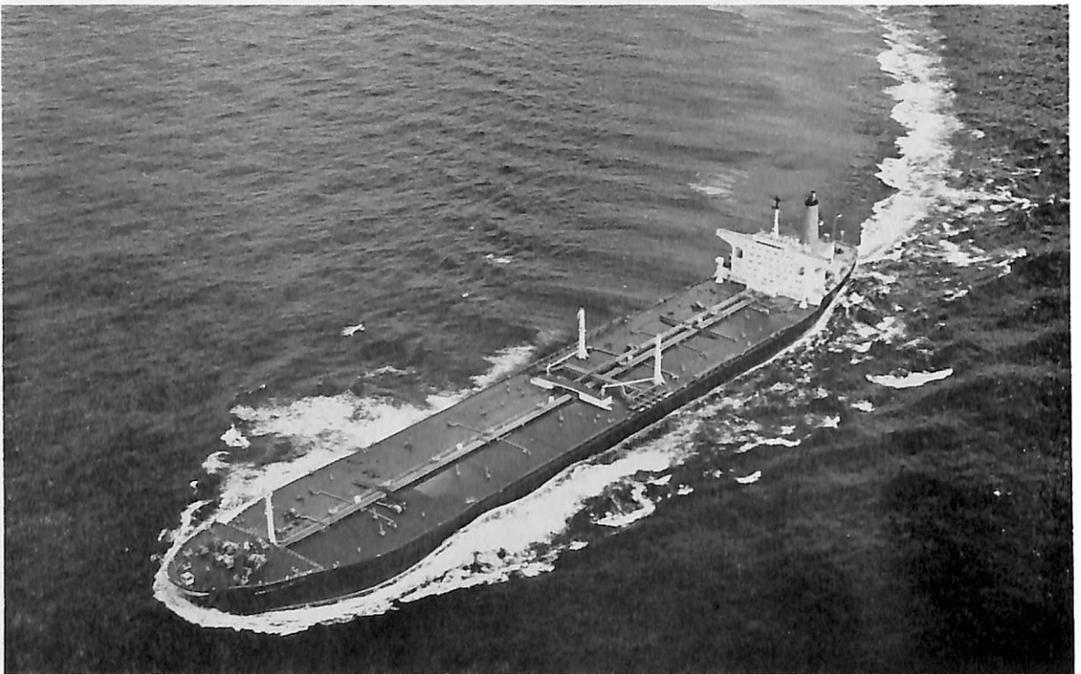
ENERGY MOBILITY (油槽船) 船主 Associated Petroleum Carriers (リベリア) 造船所 佐世保重工 業・佐世保造船所 全長 327.00 m 長(垂) 313.00 m 幅(型) 48.20 m 深(型) 25.50 m 吃水 19.90 m 総噸数 103,163.11 噸 載貨重量 218,744 噸 速力(試) 16.80 ノット (航) 16.15 ノット 主機 IHI 船用タ ービン 1 基 出力(最大) 33,000 PS 船級 LR 工期 47-3, 47-7, 47-8-31
