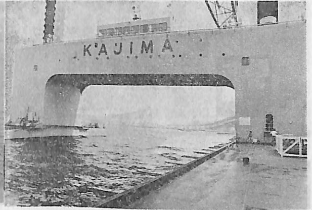
第4図 over bridge部
